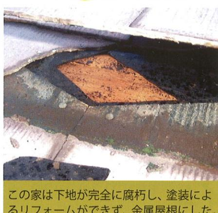
この家は下地が完全に腐朽し、塗装によるリフォームができず、金属屋根にした。
