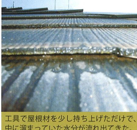
工具で屋根材を少し持ち上げただけで、中に溜まっていた水分が流れ出てきた。
