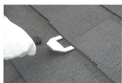
タスペーサーは、シーラー・プライマー等の下塗り後に、屋根材（約910mm）幅に対して左右15cm位のところに挿入してください。
